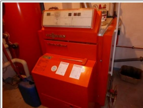
Der Heizkessel, Baujahr 1998, 22 kW
